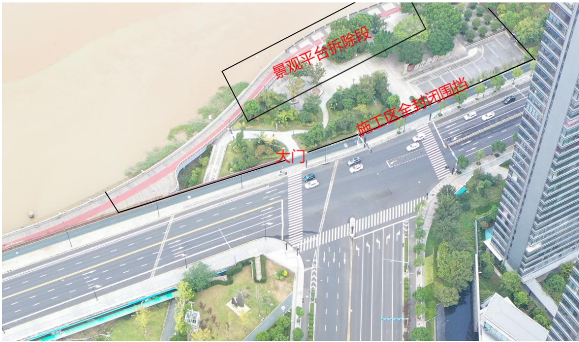
南岸防洪堤景观平台原状航拍图
